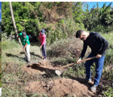
Capina e planificação da estrada SAF da EFAL.
