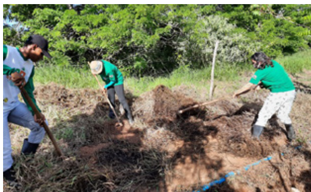
Realização da limpeza da área.
